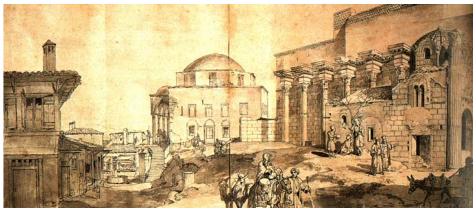
Abb. 80: Zeichnung von Karl Wilhelm von Heideck , die den nördlichen Teil der Westmauer der Hadriansbibliothek mit der angebauten Kirche (Αγίου Ασωμάτου) wiedergibt
